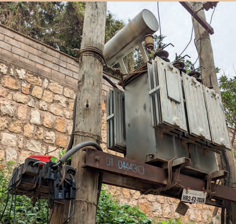
3D-Rendering der aktuellen Version des Energiesensors sowie Beispiel eines installierten Energiesensors an einem Verteiltrafo (rotes Plastikgehäuse)
